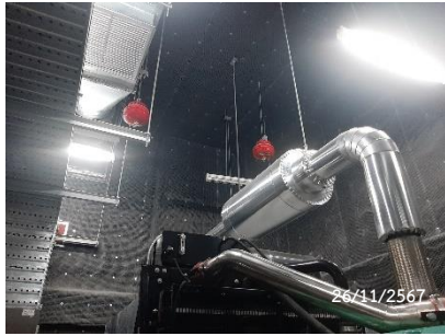
ท่อระบายไอเสีย Generator Room
